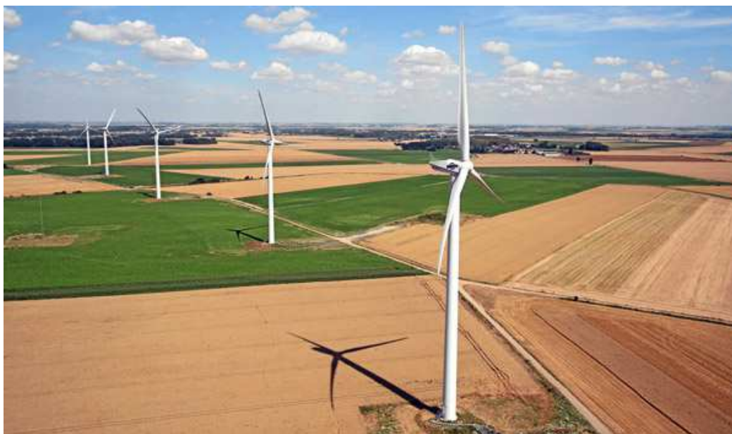
Illustration 16 : Éolien terrestre (Crédit photo : ERDF)
