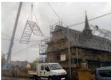
Illustration 34 : Rénovation de la chapelle Saint Jean de Langast (Crédit photo : Le Télégramme)
